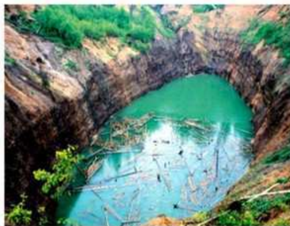
Figura 2.4 – Área Colapsada por exploração de potássio na mina de Berzhovskiy-Rússia.
